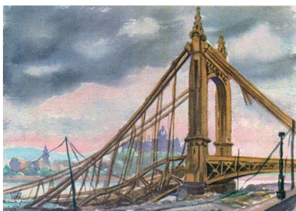
A Ferencz József Híd romjai az ideiglenes pontonhíddal és felrobbantott Erzébet Híd pesti oldala 1945 tavaszán, Blaski János
