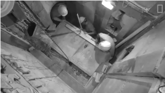
A márványlap leemelése
